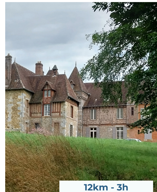
Château de St Pierre de Cernières
